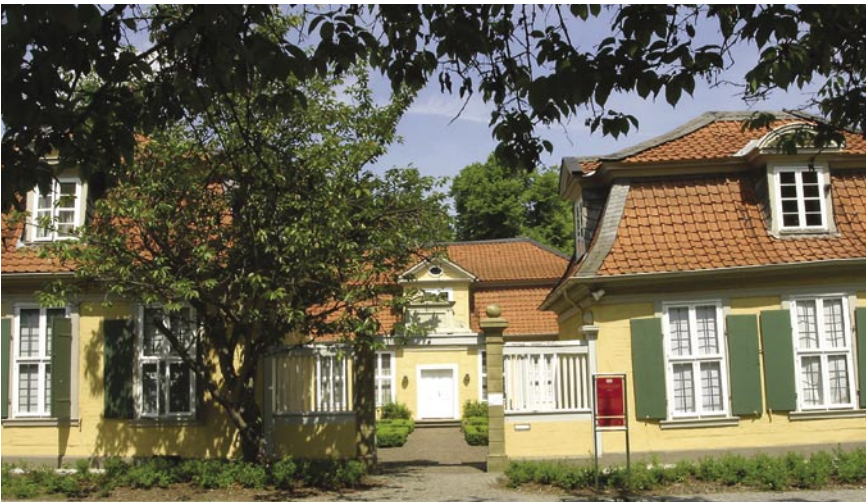
Herzog August Bibliothek Wolfenbüttel. Lessinghaus. Um 1735 von Herzog Carl I. von Braunschweig-Wolfenbüttel als Hofbeamtenhaus in Auftrag gegeben, von Lessing im Dezember 1777 bezogen. Ansicht von Süden mit Blick auf die beiden Gebäudeflügel. Foto: Udo Starke
